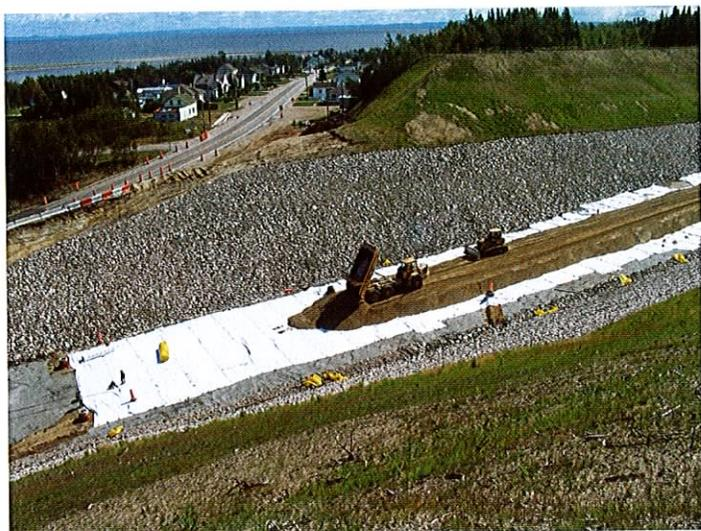
Photo 2 - Travaux de remblais - Sur une épaisseur suffisante (300-500 mm), la machinerie lourde peut remblayer sur le produit.
