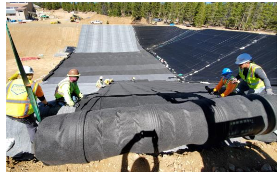
Installation du DRAINTUBE® sur les pentes. Le produit est souple et léger ce qui rend son installation aisée.
