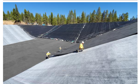
Le DRAINTUBE® est fixé par air chaud au GSB. Le géocomposite de drainage multi-linéaire protège mécaniquement la géomembrane.
