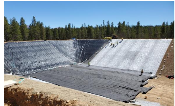
Installation du DRAINTUBE 606 ST1 D25 pour le contrôle des fuites entre la géomembrane supérieure en polyéthylène renforcé et le géosynthétique bentonitique.
